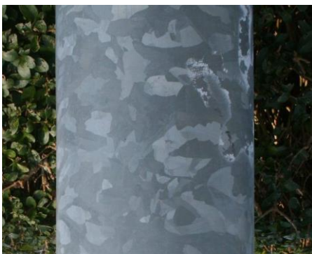
Thermisch verzinkt staal op kolommen
