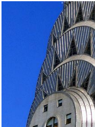
De spits van het Chrysler Building in New York City is van roestvast staal gemaakt
